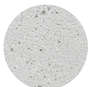
pied de mur - béton sablé
