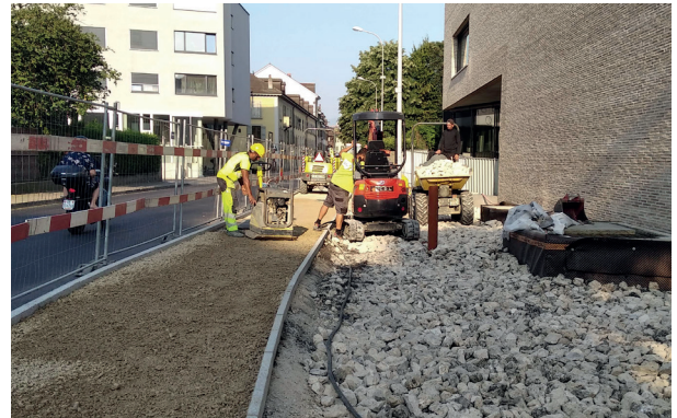
Photo du chantier | Projet Joseph-Girard, Genève
